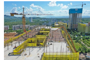
Construction 工程施工
